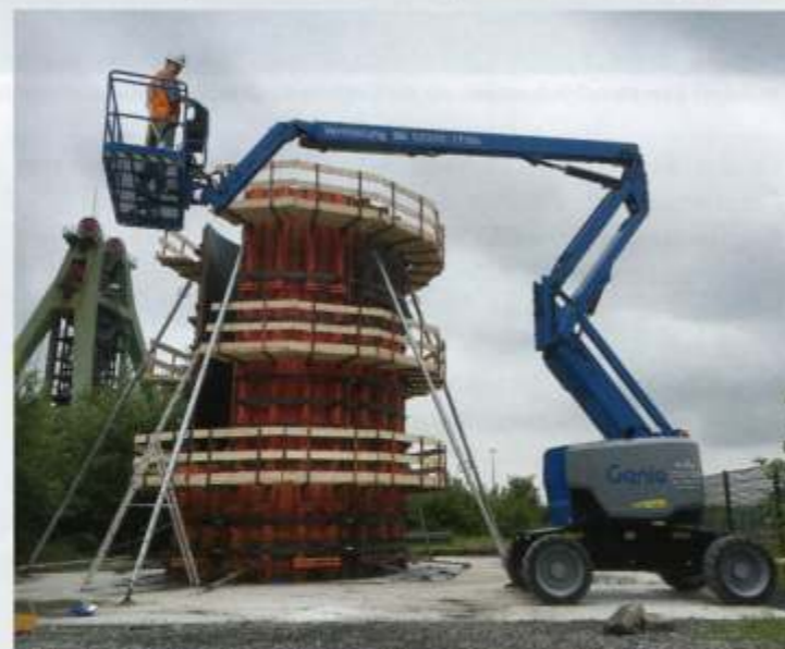
... beim Bau der Holzverschalung für den Testturm in Bottrop wertvolle Zeit.
